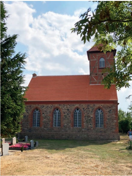
Kirche Darnewitz: Nachdem das Dach vollständig in Stand gesetzt wurde, soll im Jahr 2019 der Innenraum saniert werden.
